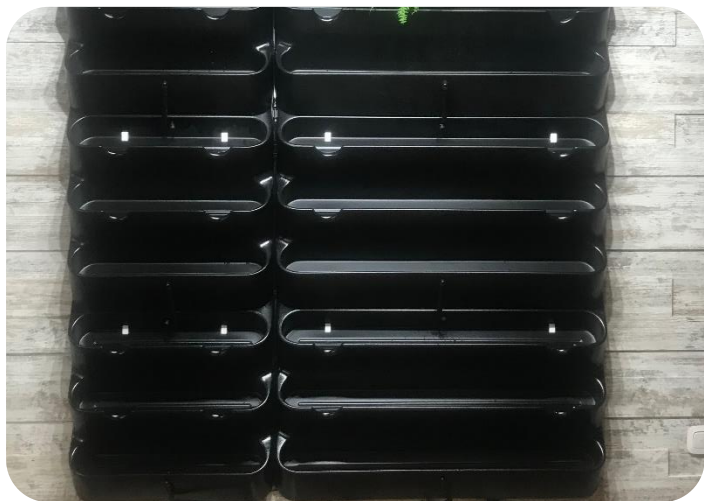
Конструкция фитостены без растений
